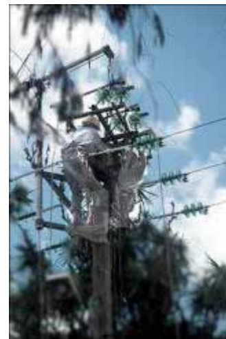
Des ouvriers de la Jirama en pleine réparation d'une ligne électrique sur un poteau à Antananarivo © DTS
