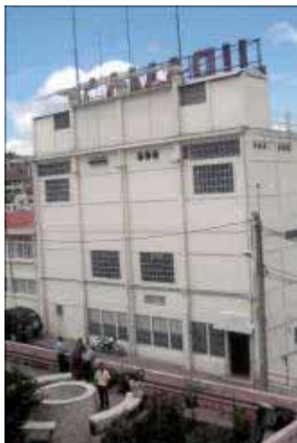
Le siège de la Direction Générale de la Jirama à Ambohitovo, Antananarivo © DTS
