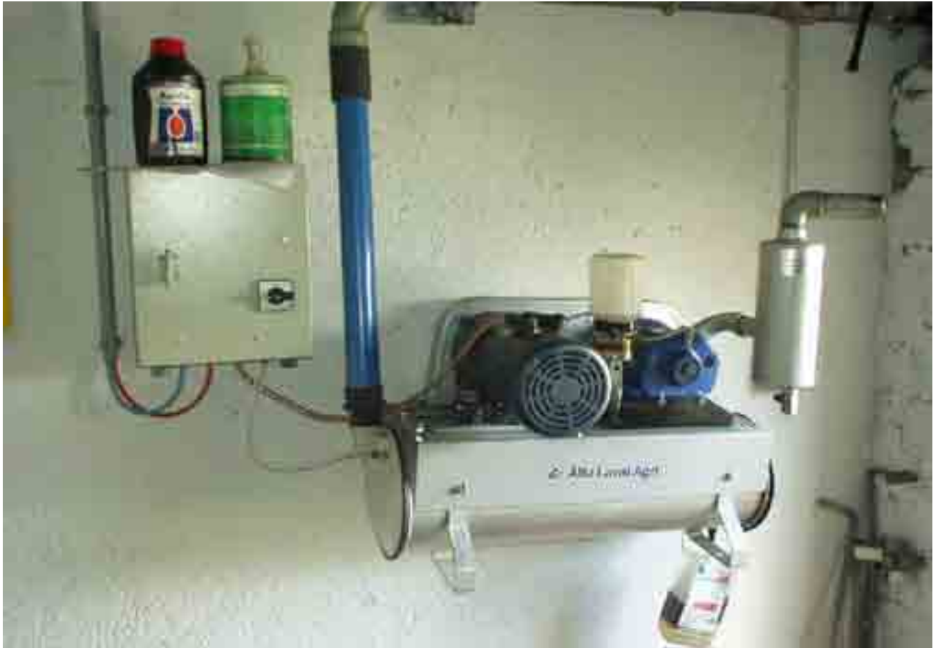
①⑦ Pompe à vide avec ballon pour traite de lait
