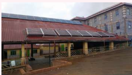
Ecole Buddo Parents Academy, panneaux photovoltaïques et capteurs thermiques (production d'eau chaude)
