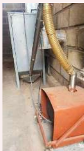
Brûleur avec son alimentation en position de fonctionnement
