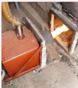
Brûleur reculé de sa position de fonctionnement pour visualiser la flamme
