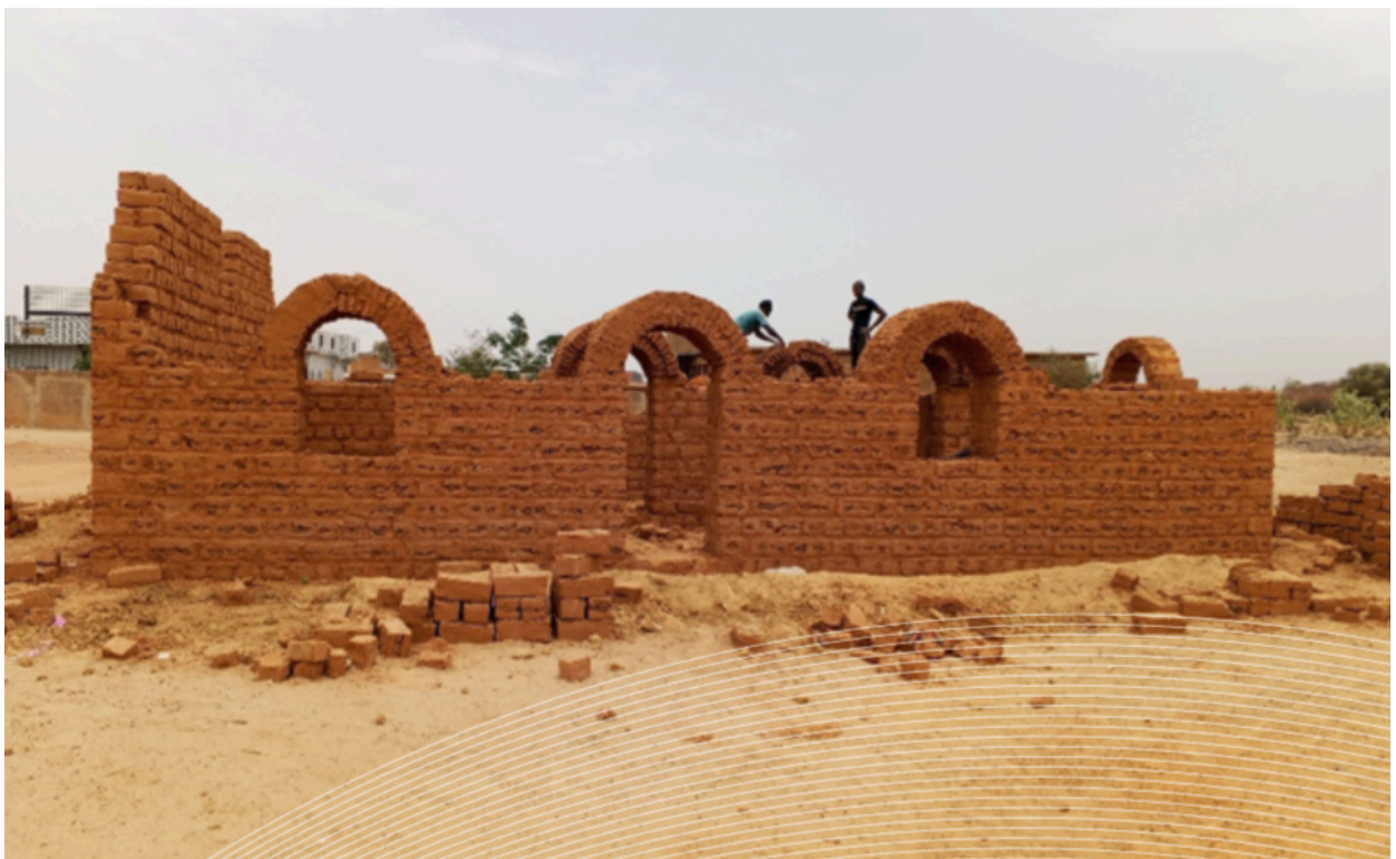
Voûte nubienne en construction. © ADSCAL
