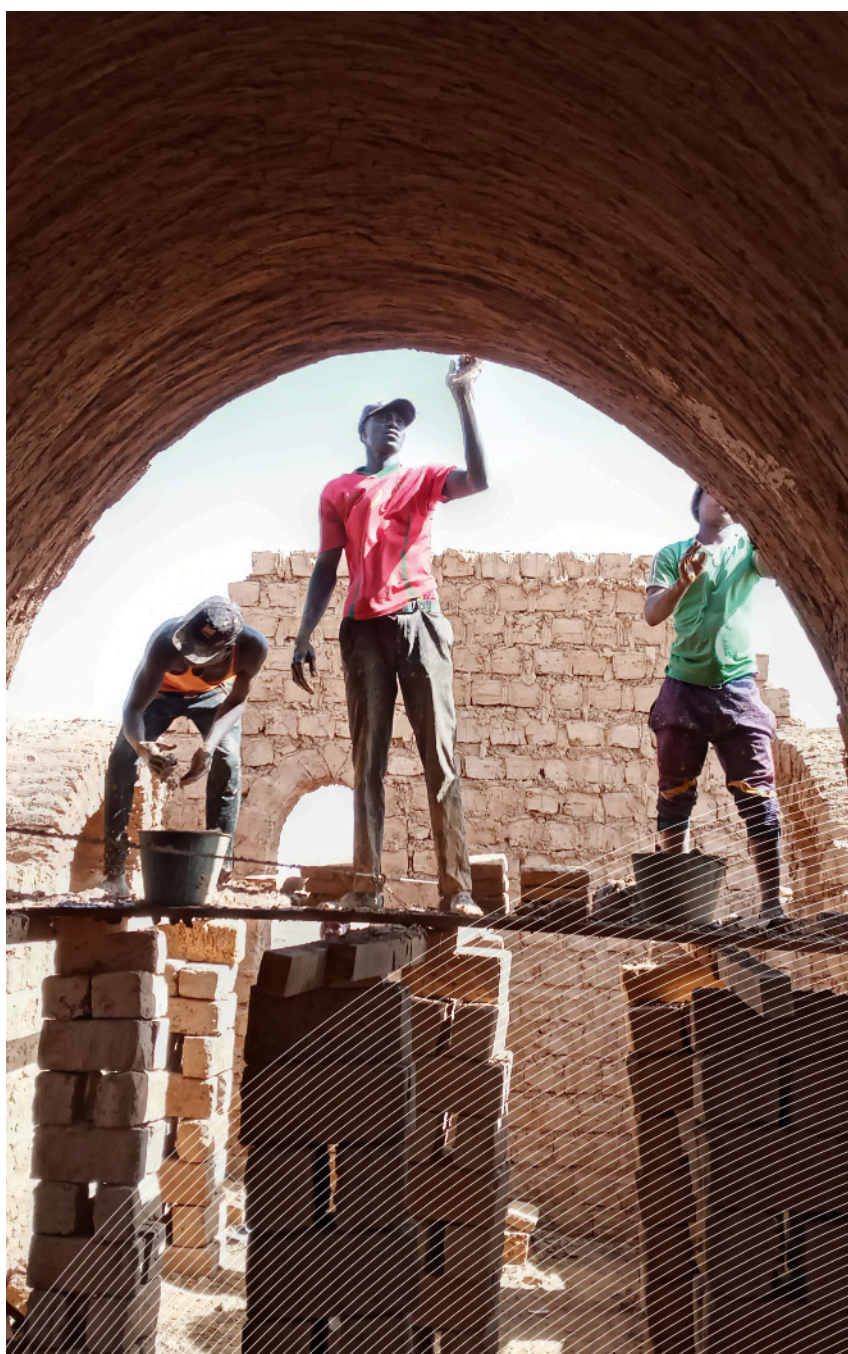
Projet de voûte Nubienne à Fouta © Le Partenariat
