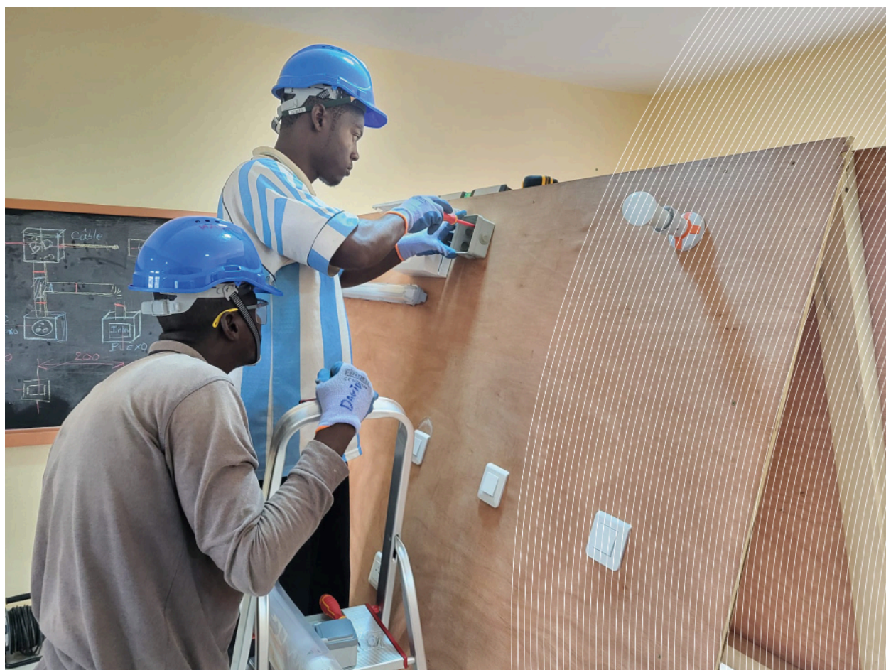
Élèves réalisant une installation intérieure. © ESF
